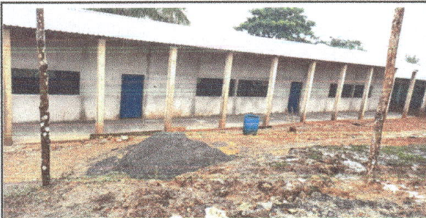
Foto 1: ESTRUCTURA DE TECHO
