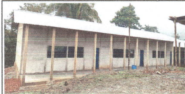
Foto 2: CUBIERTA DE LAMINA
